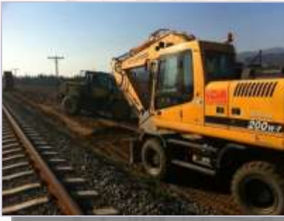
TCDD Aydın-Nazilli Arası Yol Stabilizasyon Çalışması Yapılması
