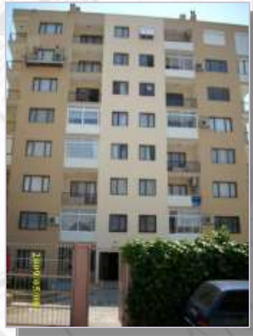
Birlik Apartmanı Dış Cephe Uygulamaları
